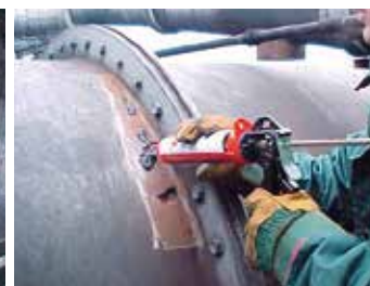
Remplissage de cavités
