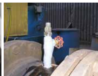
Colmatage de fuites dans la tuyauterie
