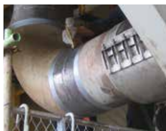
Réparation de soudures
