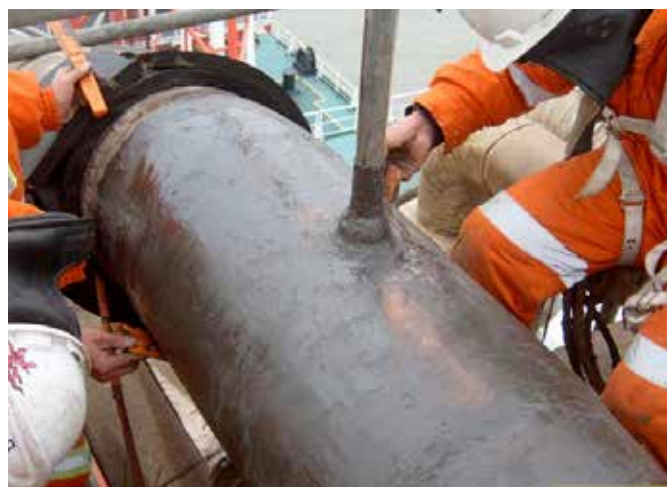
Réparation des conduites de pétrole et d'eau chaude
